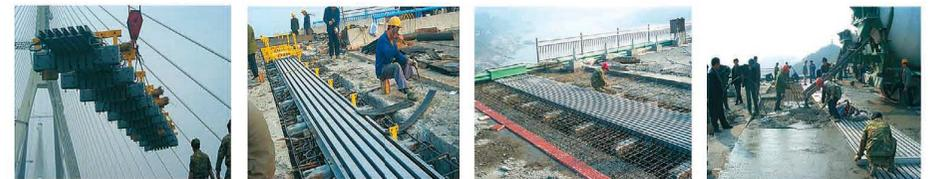
海德在桥梁装置领域拥有十多年的专业经验，具备从型钢轧制、橡胶硫化、成品加工到产品安装的规模化、专业化生产力，各类伸缩装置的制造和安装能力达到200万米/年。自主研发的超大位移桥梁伸缩装置，以及各类减震降噪桥梁伸缩装置，获得多项国家专利。
